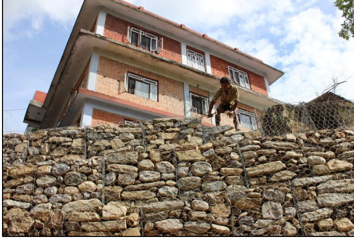
नगर पालिका परिसरमा GABION जाली लगाउँदै
