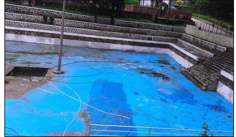
रानी पोखरी निर्माण
